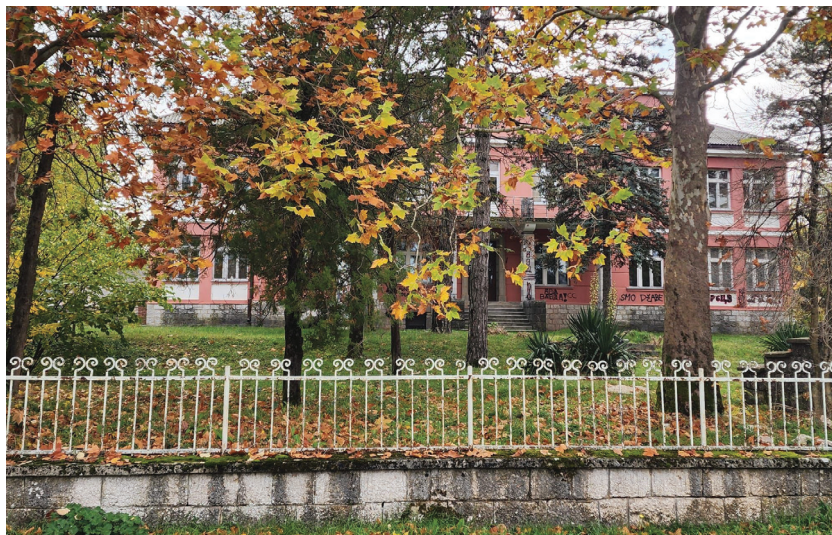
Pogled na zgradu Oficirskog doma u Bilećoj sa glavne ulice
